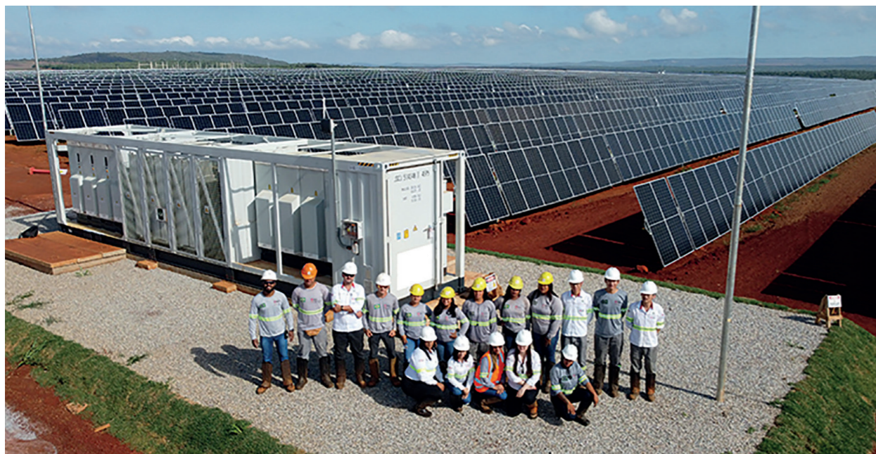
A primeira matriz fotovoltaica da Usina de Energia Solar São João, construída pela PowerChina, é conectada à rede com sucesso. Em Paracatu (MG), 14 de novembro de 2023.
